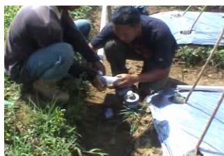
Pemasangan sprinkler pada lahan
