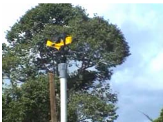
Sprinkler yang telah dipasang pada lahan
